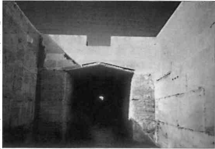
Illustration 2-4. Le troisième temple d'Osiris à Abydos. Le haut mur est au niveau du sol.
